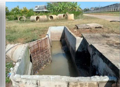
บ่อที่ ๖ ท่อส่งน้ำเสียออกจากบ่อพัก ๑
